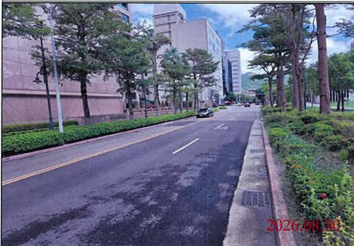
巡查日期地點：115.08.30 Y32車站 照片說明：路面狀況
