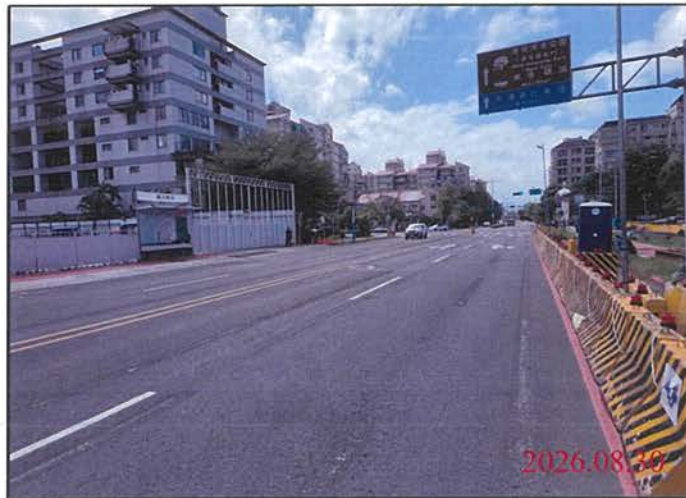
巡查日期地點：115.08.30 尾軌 照片說明：路面狀況
