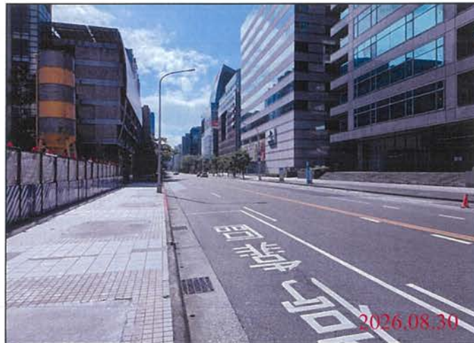
巡查日期地點：115.08.30 Y31車站 照片說明：路面狀況
