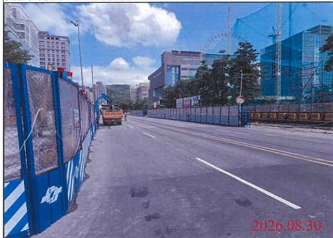
巡查日期地點：115.08.30 尾軌 照片說明：路面狀況
