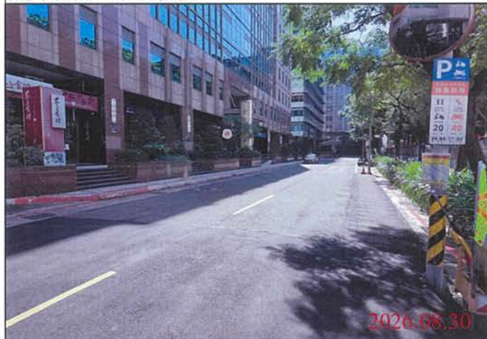
巡查日期地點：115.08.30 Y31車站 照片說明：路面狀況
