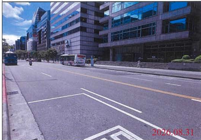
巡查日期地點：115.08.31 Y31車站 照片說明：路面狀況
