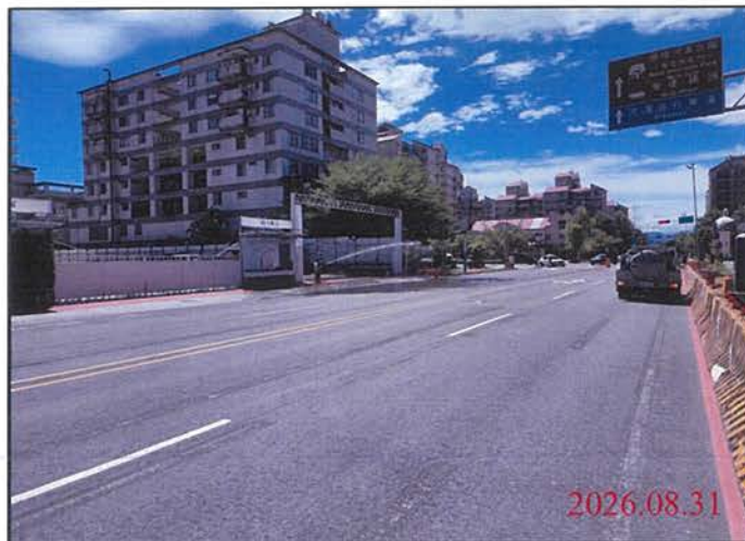
巡查日期地點：115.08.31 尾軌 照片說明：路面狀況
