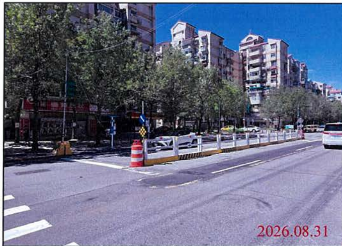
巡查日期地點：115.08.31 Y30車站 照片說明：路面狀況
