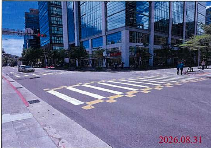
巡查日期地點：115.08.31 Y32車站 照片說明：路面狀況
