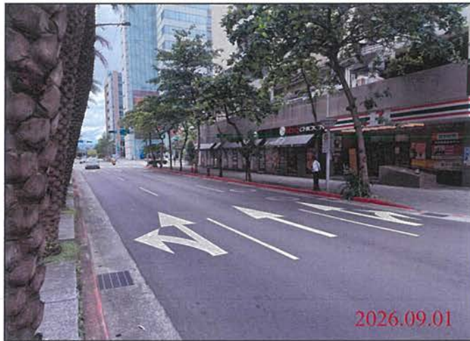
巡查日期地點：115.09.01 Y31車站 照片說明：路面狀況
