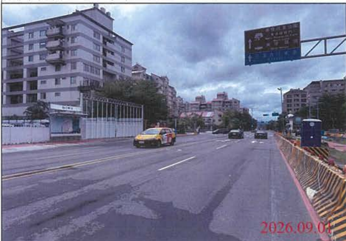
巡查日期地點：115.09.01 尾軌 照片說明：路面狀況
