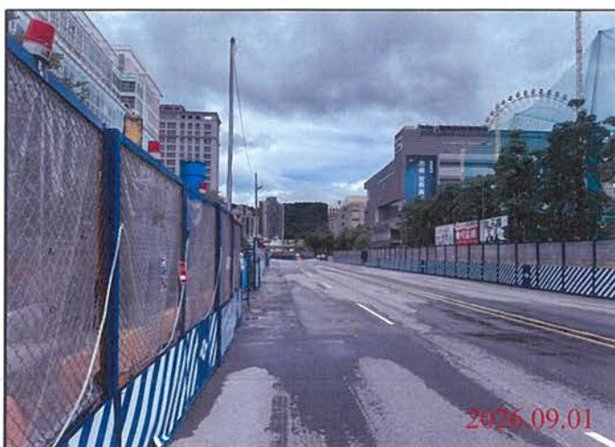
巡查日期地點：115.09.01 尾軌 照片說明：路面狀況
