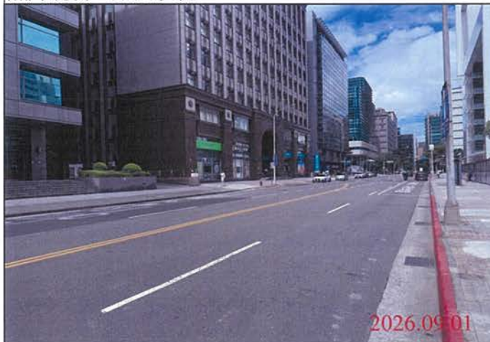
巡查日期地點：115.09.01 Y31車站 照片說明：路面狀況
