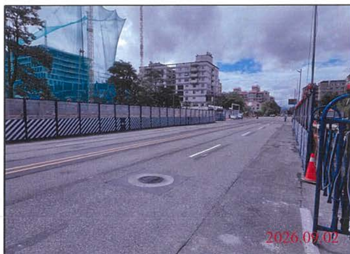
巡查日期地點：115.09.02 尾軌 照片說明：路面狀況
