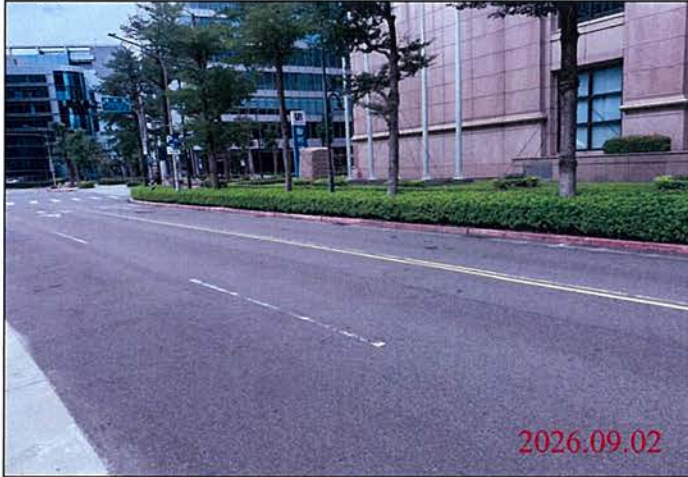
巡查日期地點：115.09.02 Y32車站 照片說明：路面狀況
