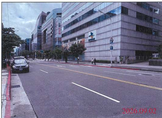
巡查日期地點：115.09.02 Y31車站 照片說明：路面狀況
