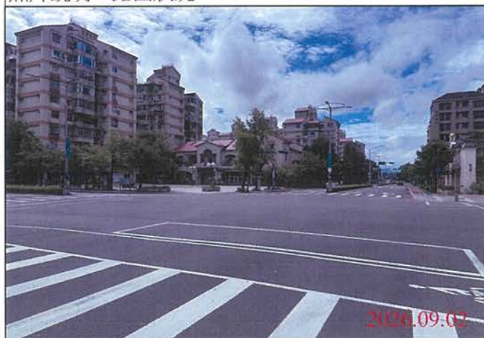
巡查日期地點：115.09.02 尾軌 照片說明：路面狀況
