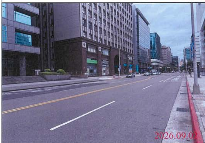
巡查日期地點：115.09.02 Y31車站 照片說明：路面狀況
