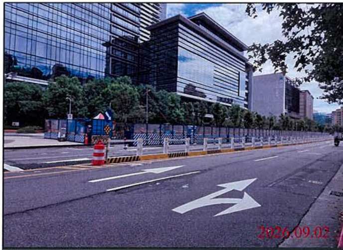
巡查日期地點：115.09.02 Y30車站 照片說明：路面狀況
