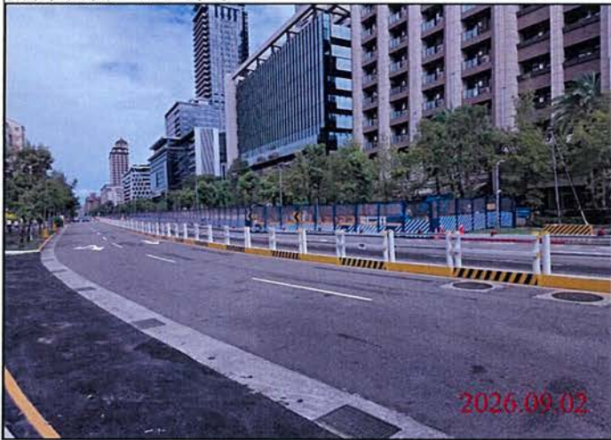
巡查日期地點：115.09.02 Y30車站 照片說明：路面狀況
