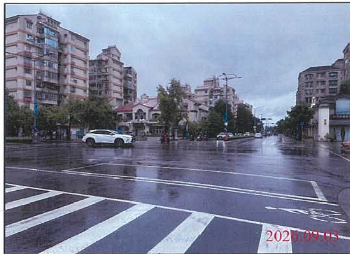
巡查日期地點：115.09.03 尾軌 照片說明：路面狀況
