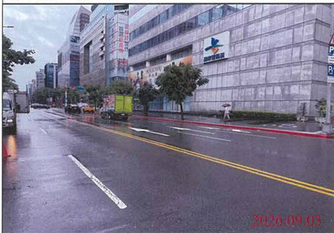
巡查日期地點：115.09.03 Y31車站 照片說明：路面狀況
