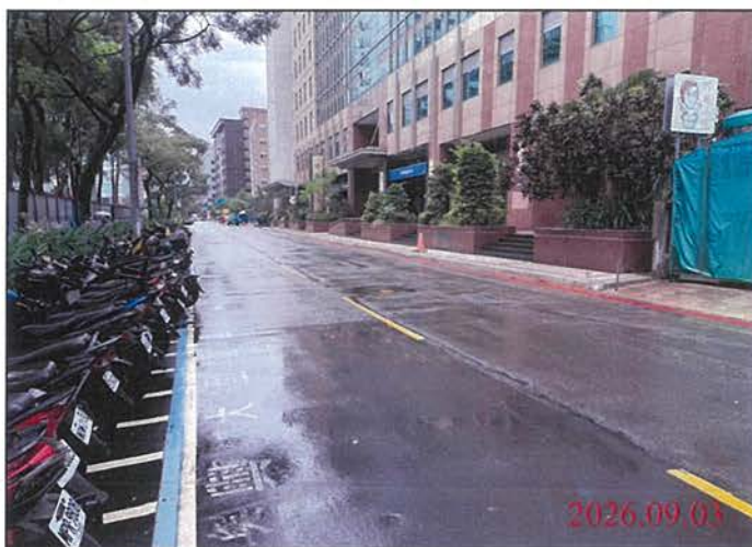
巡查日期地點：115.09.03 Y31車站 照片說明：路面狀況
