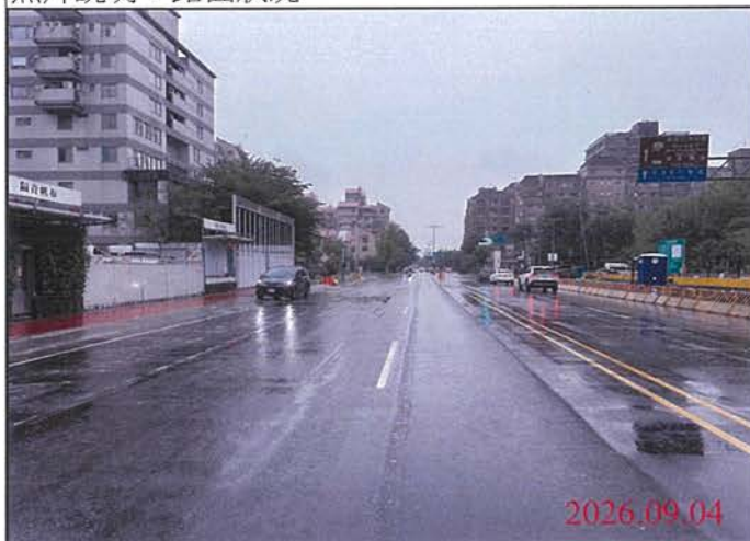
巡查日期地點：115.09.04 尾軌 照片說明：路面狀況
