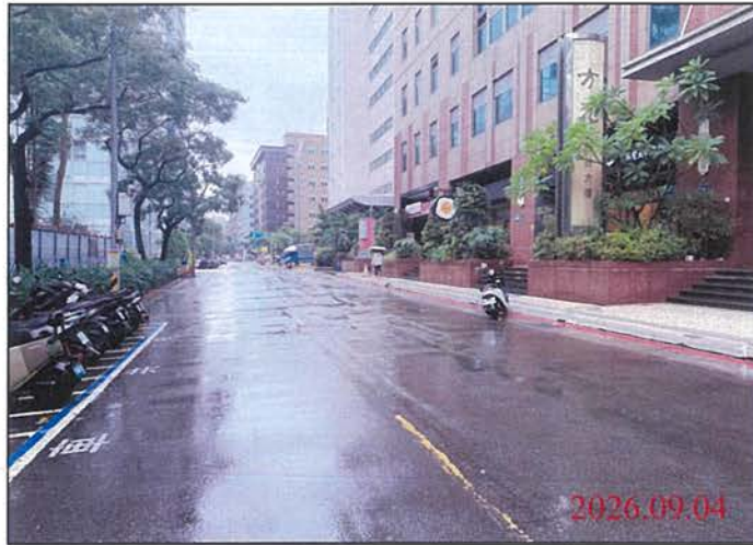
巡查日期地點：115.09.04 Y31車站 照片說明：路面狀況
