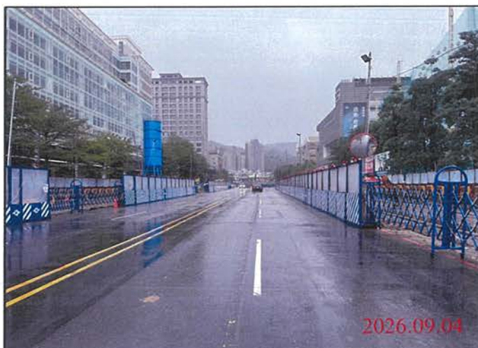
巡查日期地點：115.09.04 尾軌 照片說明：路面狀況
