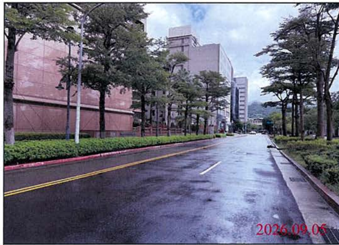
巡查日期地點：115.09.05 Y32車站 照片說明：路面狀況
