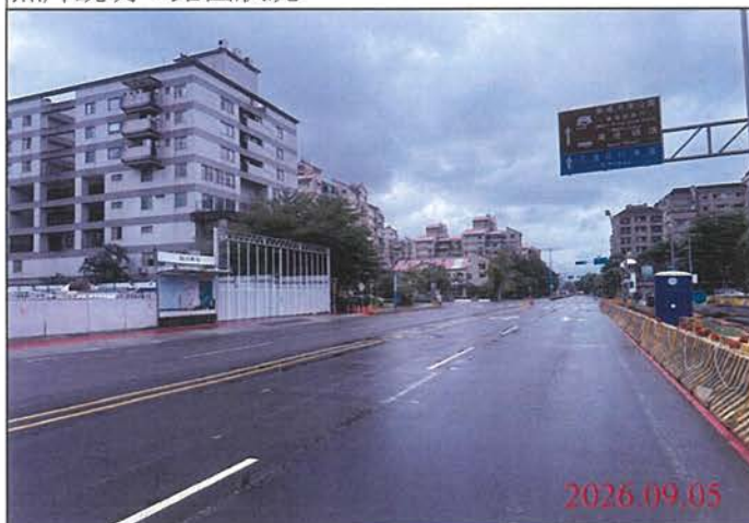
巡查日期地點：115.09.05 尾軌 照片說明：路面狀況
