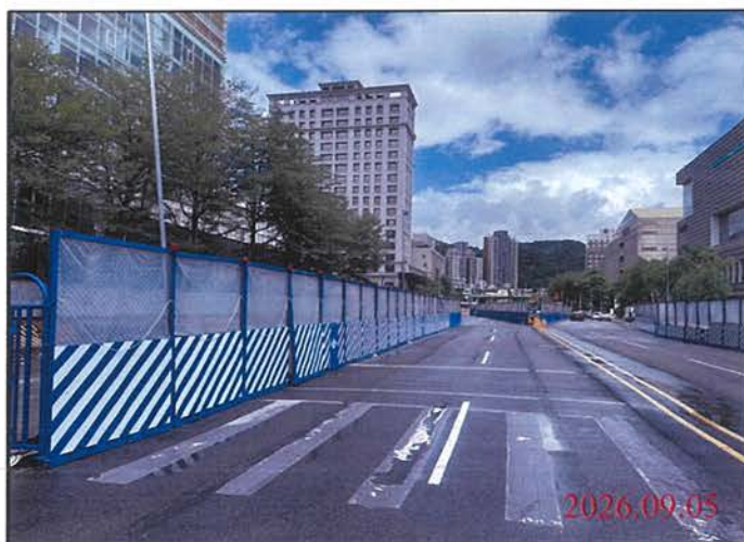
巡查日期地點：115.09.05 尾軌 照片說明：路面狀況
