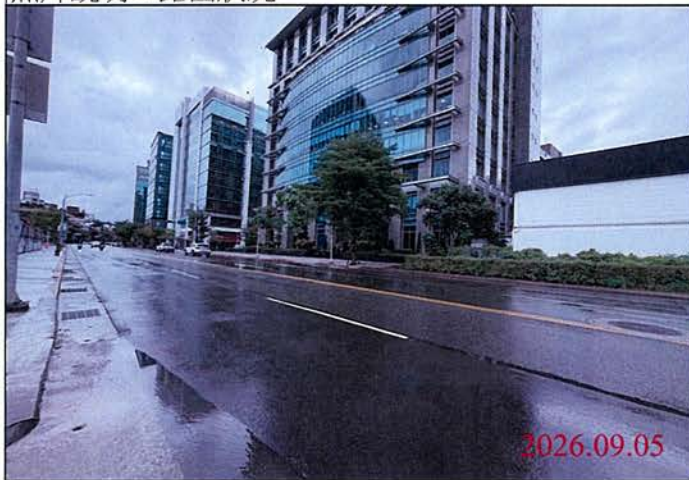
巡查日期地點：115.09.05 Y32車站 照片說明：路面狀況
