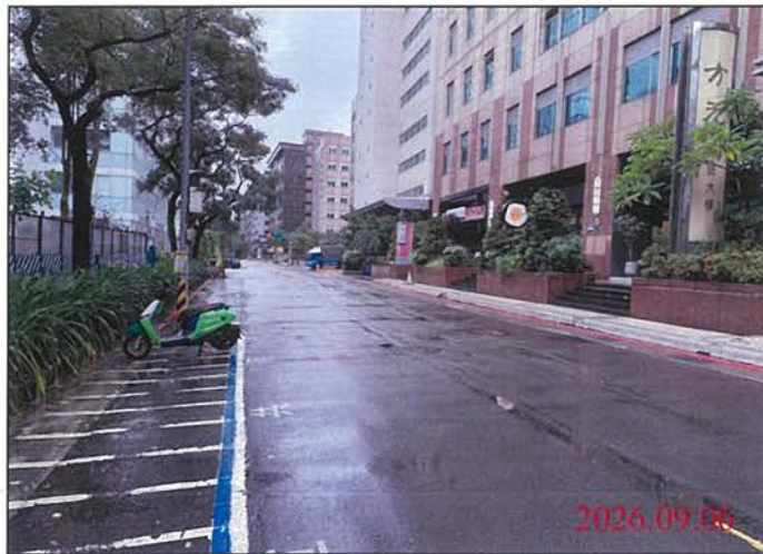
巡查日期地點：115.09.06 Y31車站 照片說明：路面狀況
