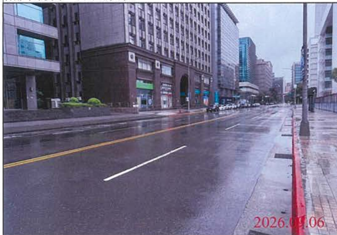
巡查日期地點：115.09.06 Y31車站 照片說明：路面狀況
