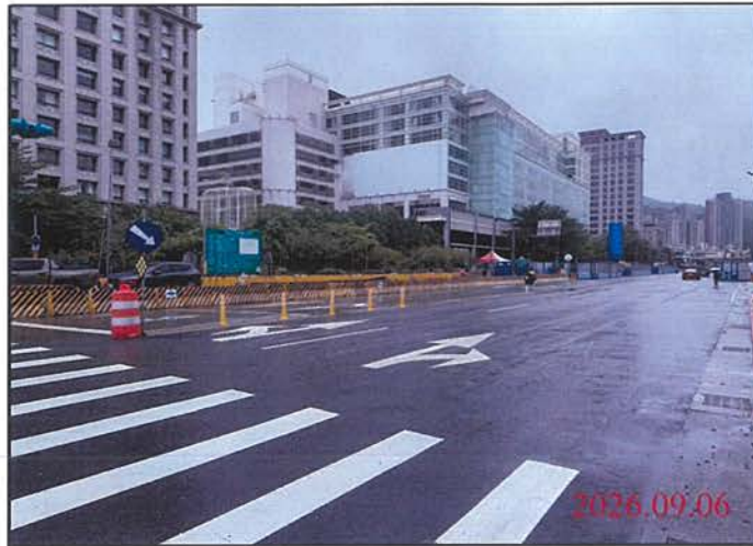
巡查日期地點：115.09.06 尾軌 照片說明：路面狀況
