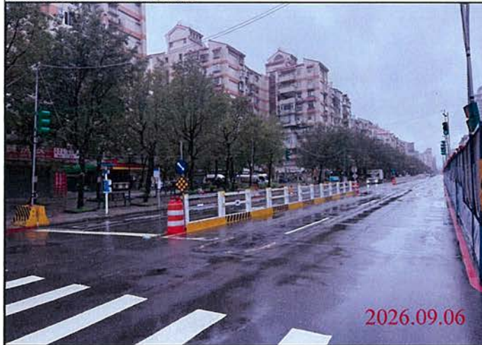
巡查日期地點：115.09.06 Y30車站 照片說明：路面狀況
