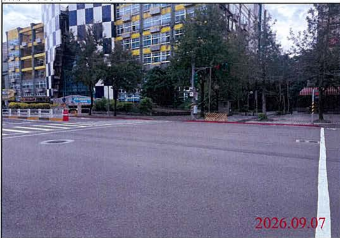
巡查日期地點：115.09.07 Y30車站 照片說明：路面狀況
