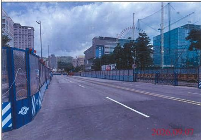
巡查日期地點：115.09.07 尾軌 照片說明：路面狀況
