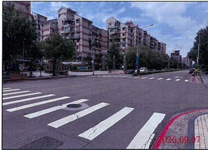
巡查日期地點：115.09.07 Y30車站 照片說明：路面狀況
