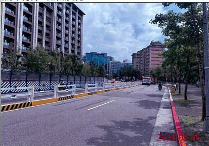
巡查日期地點：115.09.08 Y30車站 照片說明：路面狀況
