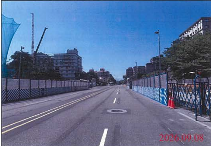
巡查日期地點：115.09.08 尾軌 照片說明：路面狀況
