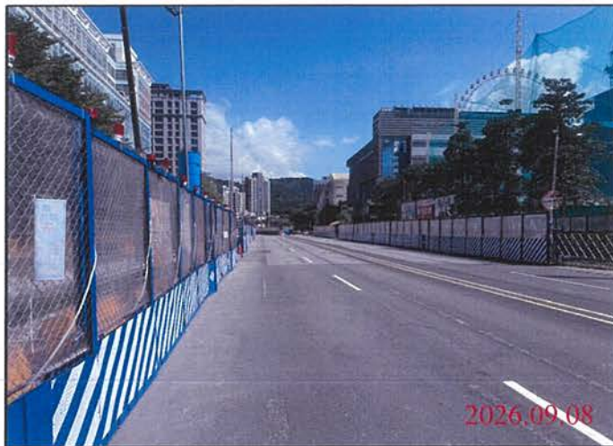
巡查日期地點：115.09.08 尾軌 照片說明：路面狀況
