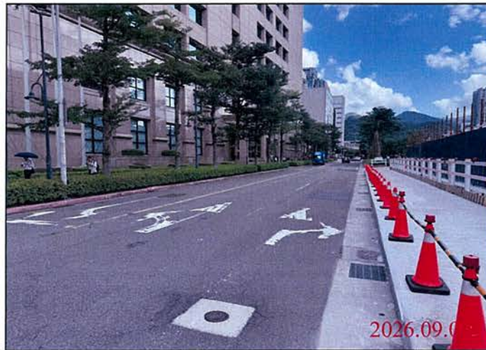
巡查日期地點：115.09.09 Y32車站 照片說明：路面狀況
