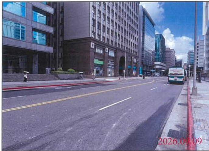
巡查日期地點：115.09.09 Y31車站 照片說明：路面狀況
