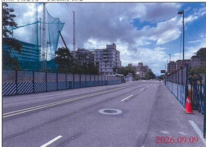
巡查日期地點：115.09.09 尾軌 照片說明：路面狀況
