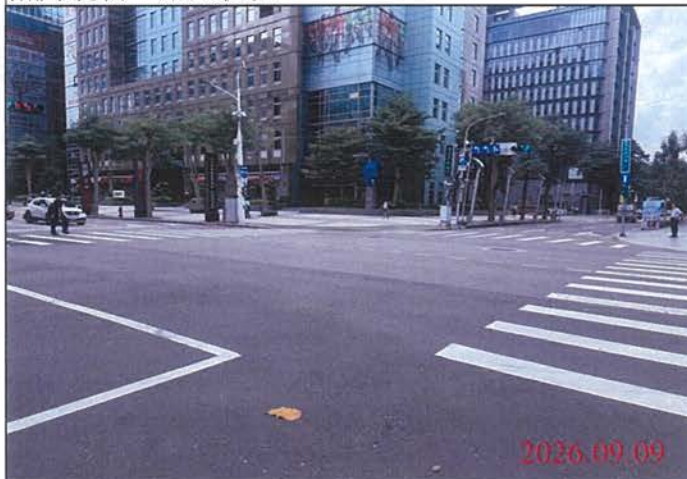
巡查日期地點：115.09.09 Y31車站 照片說明：路面狀況
