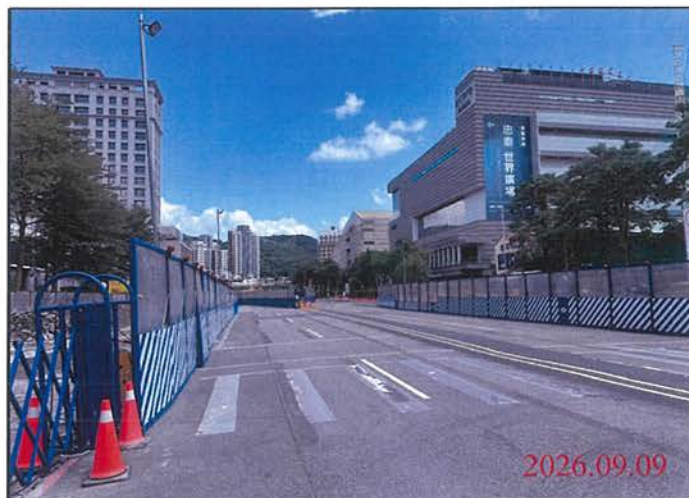
巡查日期地點：115.09.09 尾軌 照片說明：路面狀況
