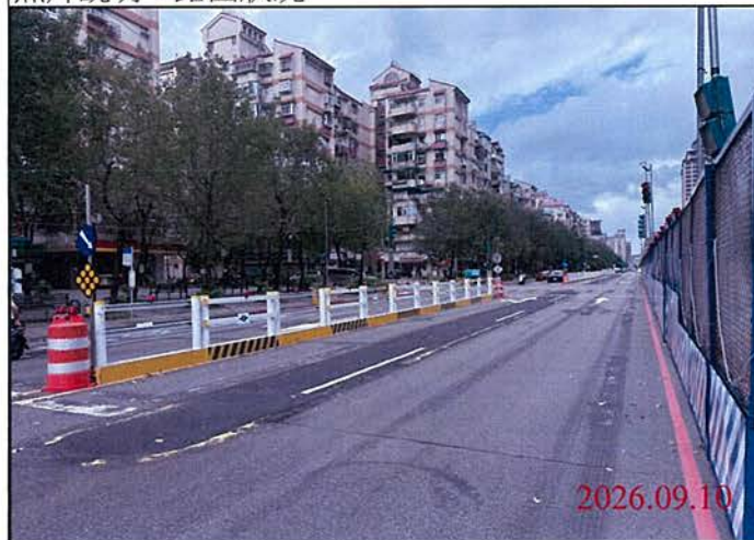
巡查日期地點：115.09.10 Y30車站 照片說明：路面狀況
