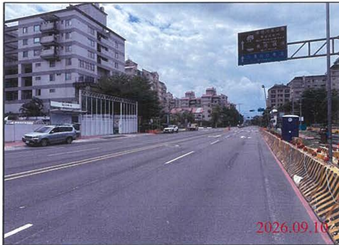
巡查日期地點：115.09.10 尾軌 照片說明：路面狀況
