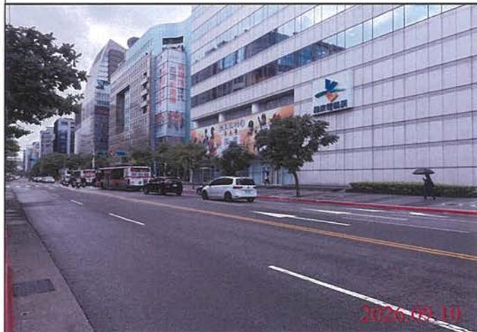
巡查日期地點：115.09.10 Y31車站 照片說明：路面狀況
