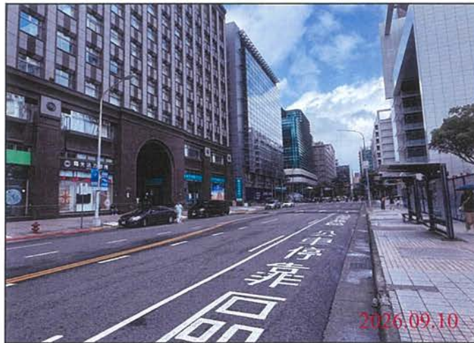
巡查日期地點：115.09.10 Y31車站 照片說明：路面狀況
