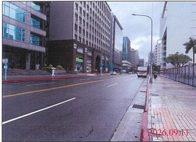
巡查日期地點：115.09.11 Y31車站 照片說明：路面狀況
