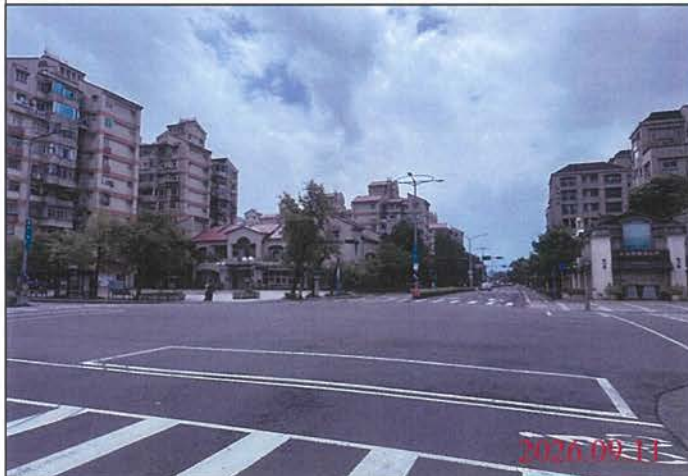
巡查日期地點：115.09.11 尾軌 照片說明：路面狀況
