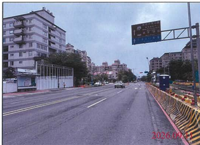
巡查日期地點：115.09.11 尾軌 照片說明：路面狀況
