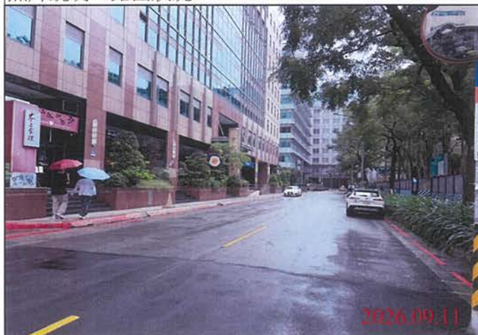
巡查日期地點：115.09.11 Y31車站 照片說明：路面狀況
