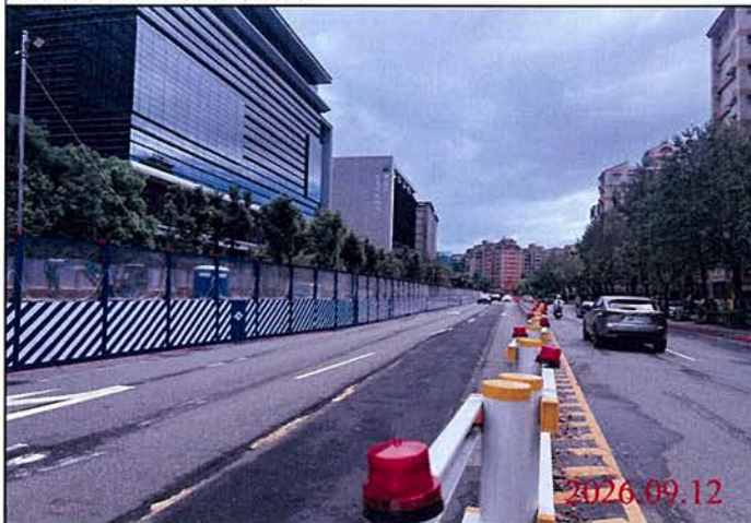
巡查日期地點：115.09.12 Y30車站 照片說明：路面狀況
