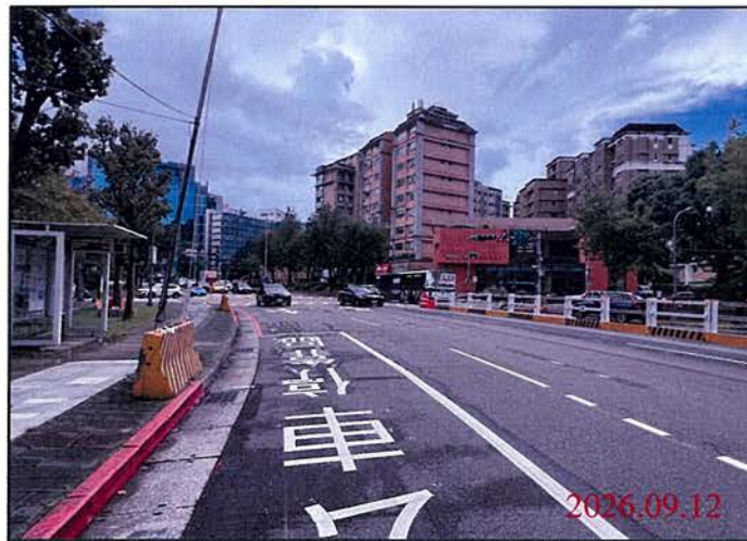
巡查日期地點：115.09.12 Y30車站 照片說明：路面狀況
