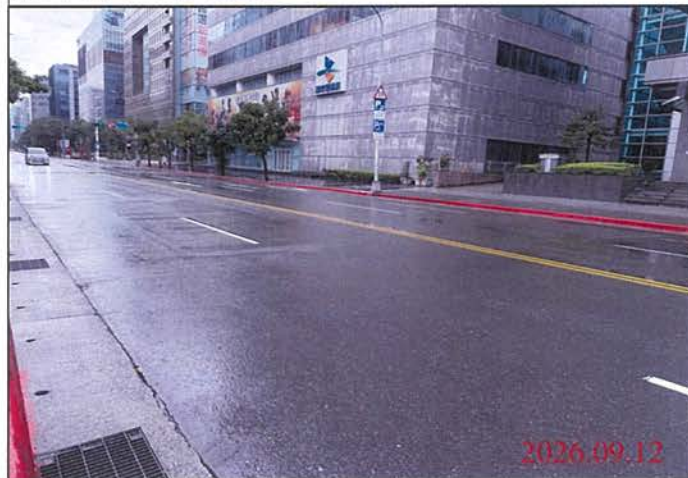
巡查日期地點：115.09.12 Y31車站 照片說明：路面狀況
