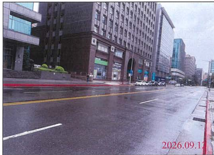
巡查日期地點：115.09.12 Y31車站 照片說明：路面狀況
