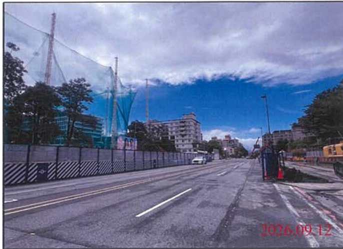
巡查日期地點：115.09.12 尾軌 照片說明：路面狀況
