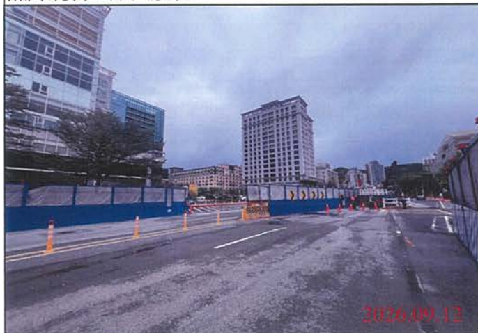
巡查日期地點：115.09.12 尾軌 照片說明：路面狀況
