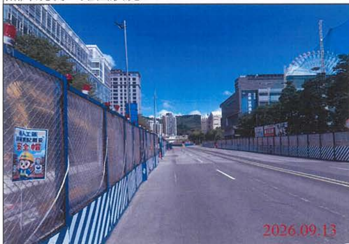
巡查日期地點：115.09.13 尾軌 照片說明：路面狀況
