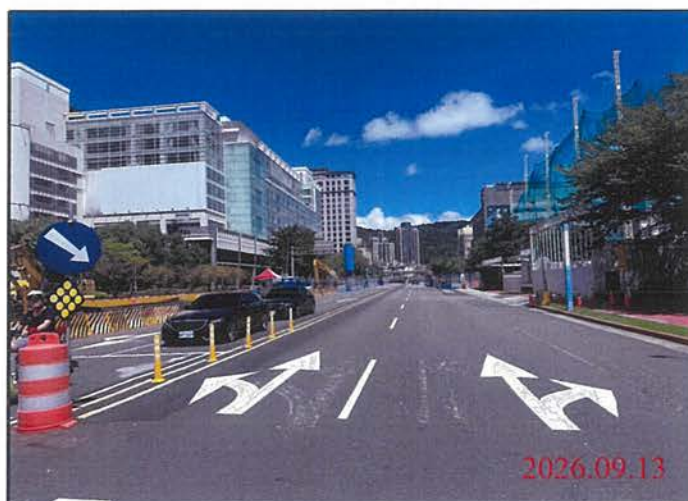
巡查日期地點：115.09.13 尾軌 照片說明：路面狀況
