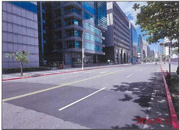
巡查日期地點：115.09.13 Y31車站 照片說明：路面狀況
