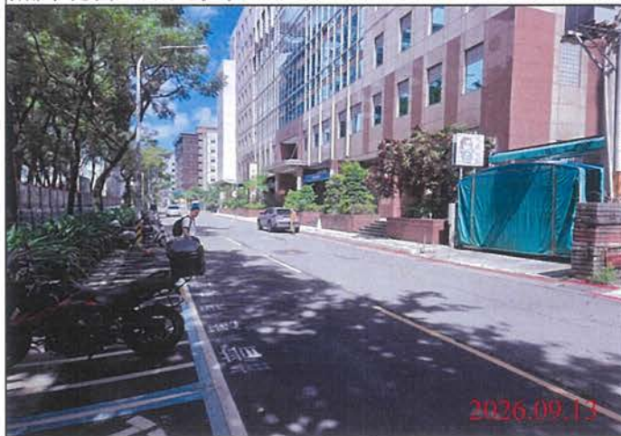
巡查日期地點：115.09.13 Y31車站 照片說明：路面狀況
