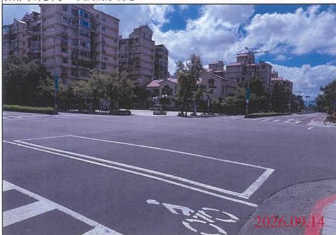
巡查日期地點：115.09.14 尾軌 照片說明：路面狀況
