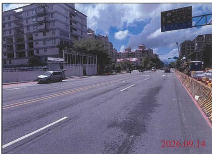
巡查日期地點：115.09.14 尾軌 照片說明：路面狀況
