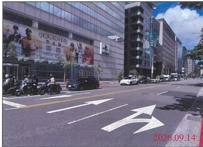
巡查日期地點：115.09.14 Y31車站 照片說明：路面狀況
