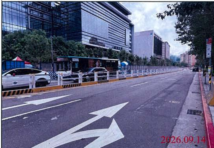
巡查日期地點：115.09.14 Y30車站 照片說明：路面狀況
