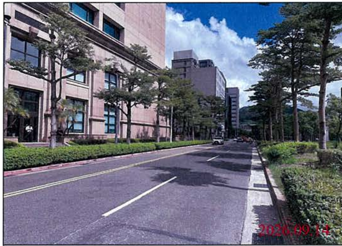
巡查日期地點：115.09.14 Y32車站 照片說明：路面狀況
