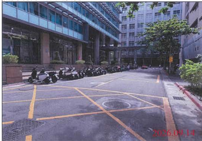
巡查日期地點：115.09.14 Y31車站 照片說明：路面狀況
