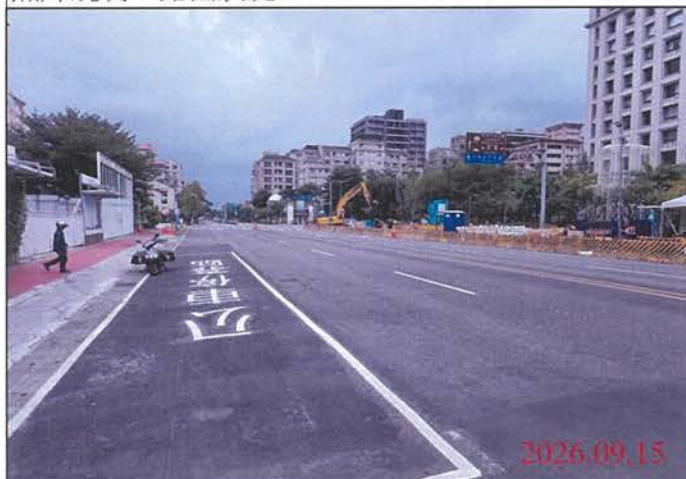
巡查日期地點：115.09.15 尾軌 照片說明：路面狀況
