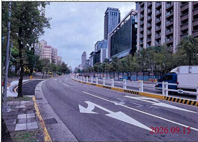
巡查日期地點：115.09.15 Y30車站 照片說明：路面狀況
