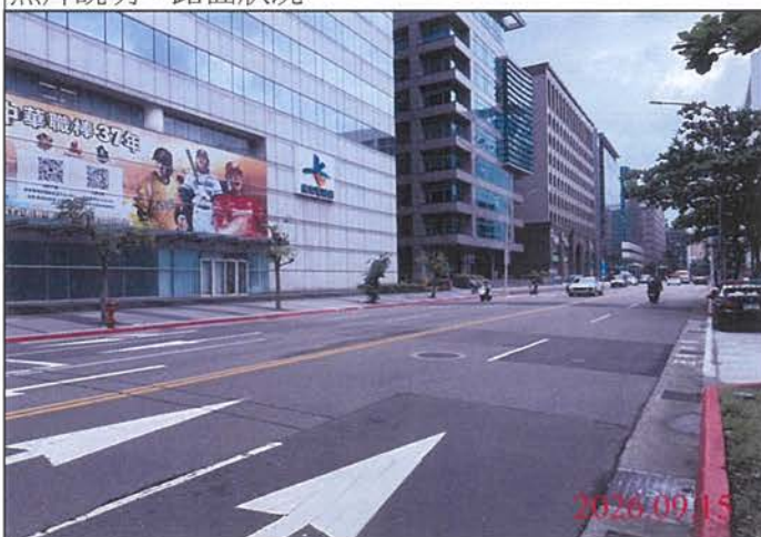
巡查日期地點：115.09.15 Y31車站 照片說明：路面狀況
