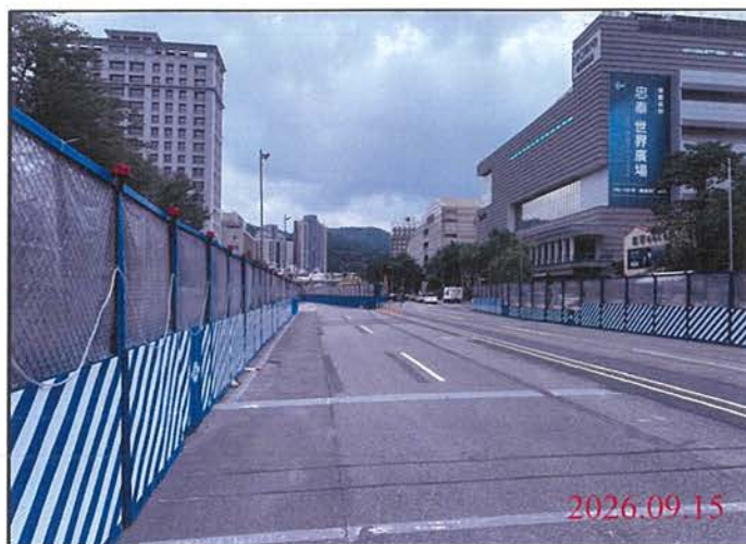
巡查日期地點：115.09.15 尾軌 照片說明：路面狀況
