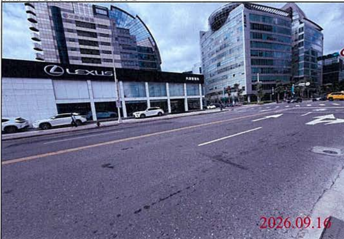
巡查日期地點：115.09.16 Y32車站 照片說明：路面狀況
