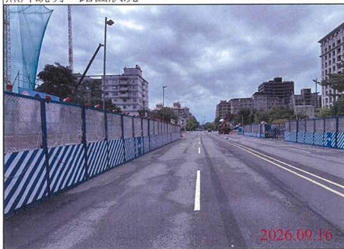
巡查日期地點：115.09.16 尾軌 照片說明：路面狀況
