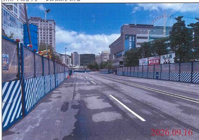
巡查日期地點：115.09.16 尾軌 照片說明：路面狀況
