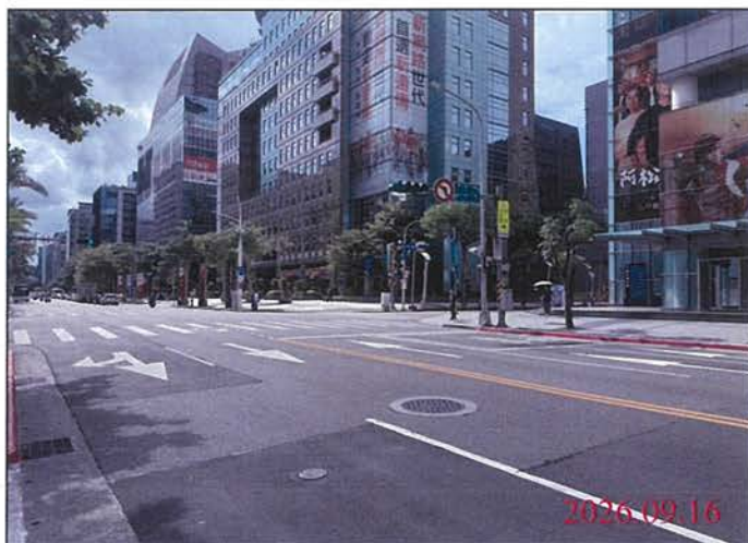
巡查日期地點：115.09.16 Y31車站 照片說明：路面狀況
