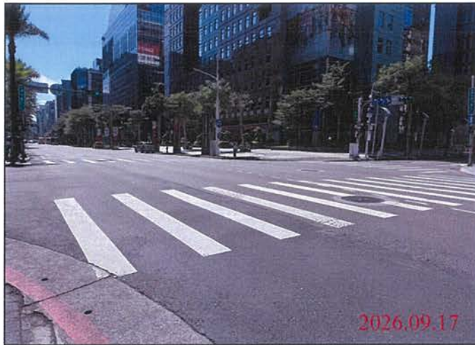
巡查日期地點：115.09.17 Y31車站 照片說明：路面狀況
