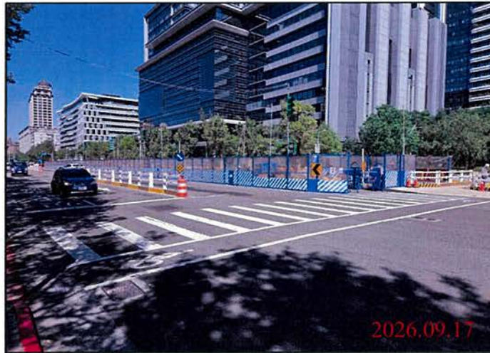
巡查日期地點：115.09.17 Y30車站 照片說明：路面狀況
