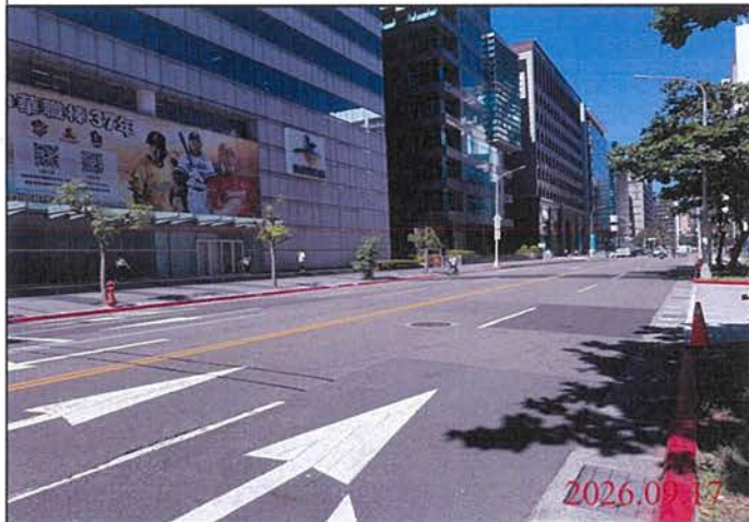
巡查日期地點：115.09.17 Y31車站 照片說明：路面狀況
