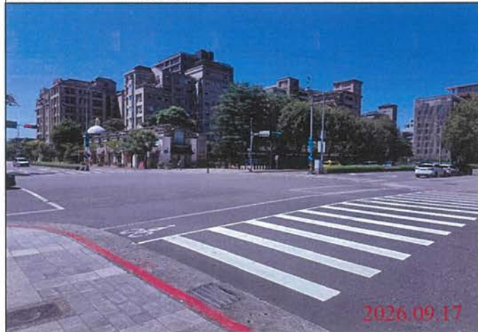
巡查日期地點：115.09.17 尾軌 照片說明：路面狀況
