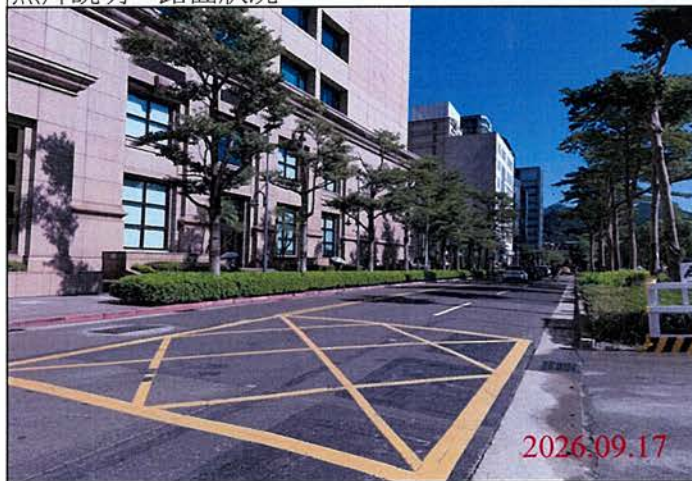
巡查日期地點：115.09.17 Y32車站 照片說明：路面狀況
