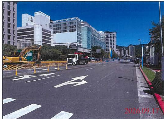
巡查日期地點：115.09.17 尾軌 照片說明：路面狀況
