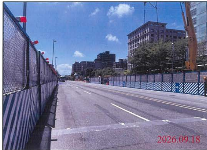
巡查日期地點：115.09.18 尾軌 照片說明：路面狀況
