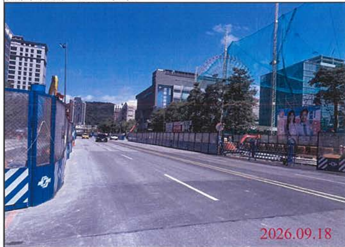
巡查日期地點：115.09.18 尾軌 照片說明：路面狀況
