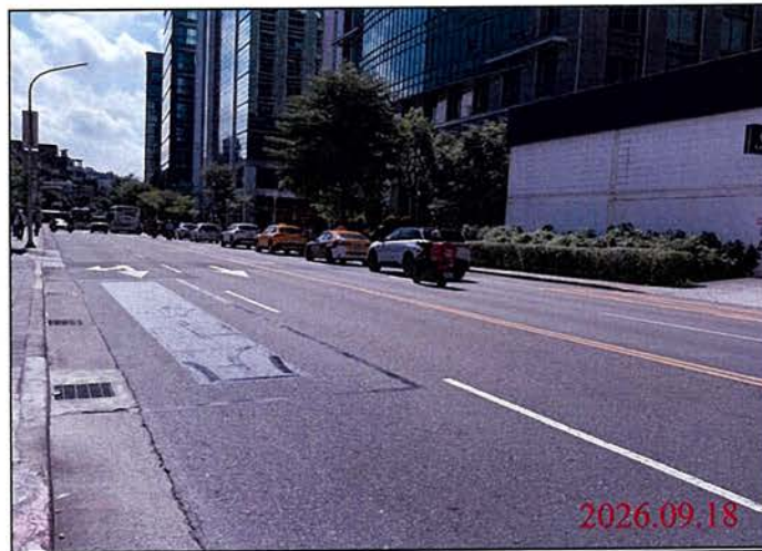
巡查日期地點：115.09.18 Y32車站 照片說明：路面狀況
