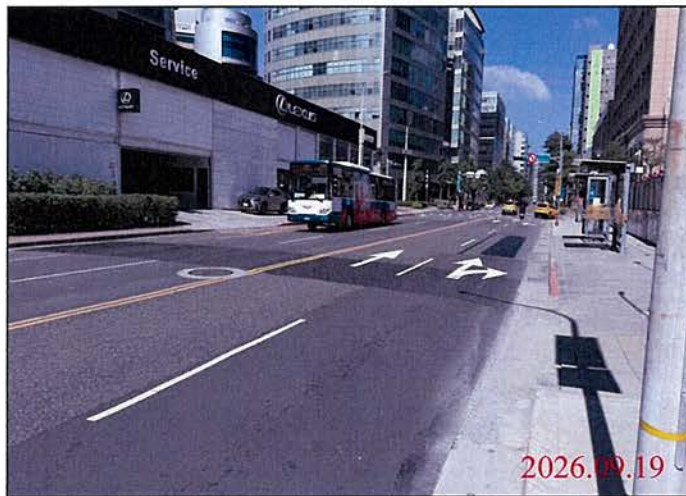
巡查日期地點：115.09.19 Y32車站 照片說明：路面狀況
