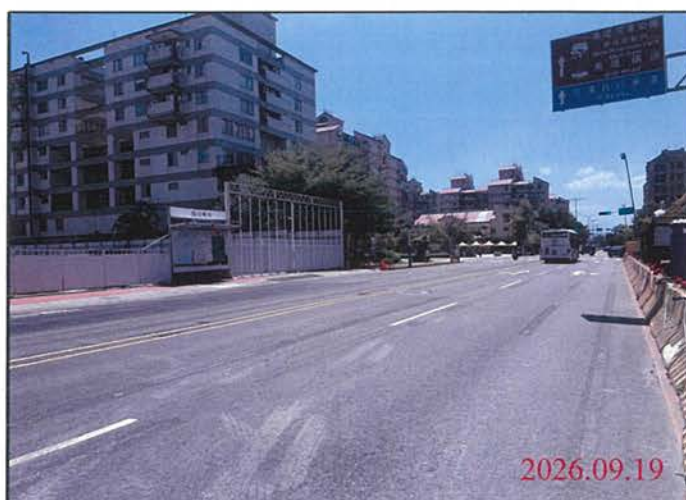
巡查日期地點：115.09.19 尾軌 照片說明：路面狀況
