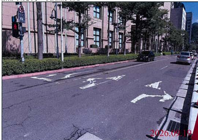
巡查日期地點：115.09.19 Y32車站 照片說明：路面狀況
