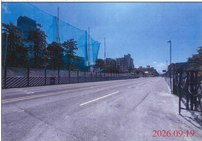
巡查日期地點：115.09.19 尾軌 照片說明：路面狀況
