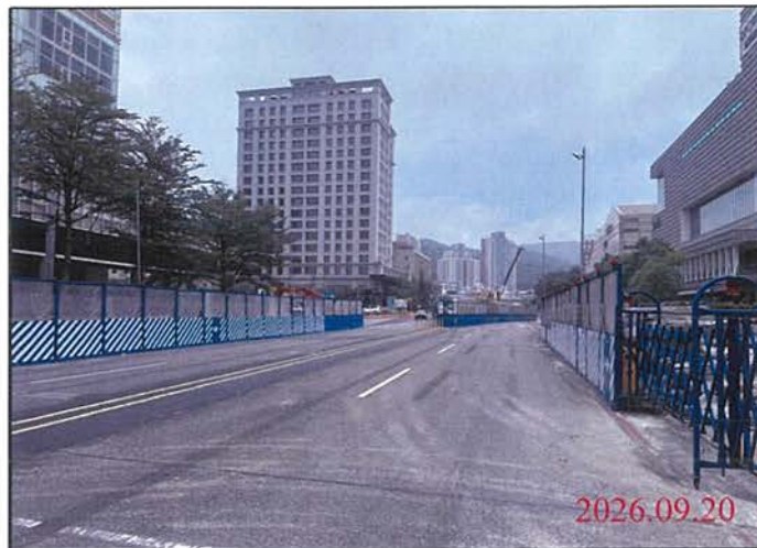
巡查日期地點：115.09.20 尾軌 照片說明：路面狀況
