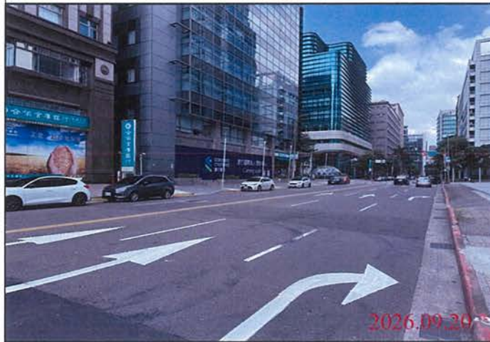
巡查日期地點：115.09.20 Y31車站 照片說明：路面狀況
