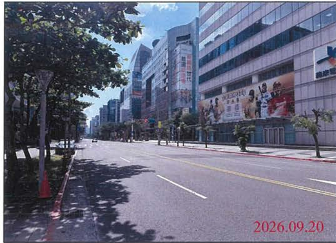
巡查日期地點：115.09.20 Y31車站 照片說明：路面狀況
