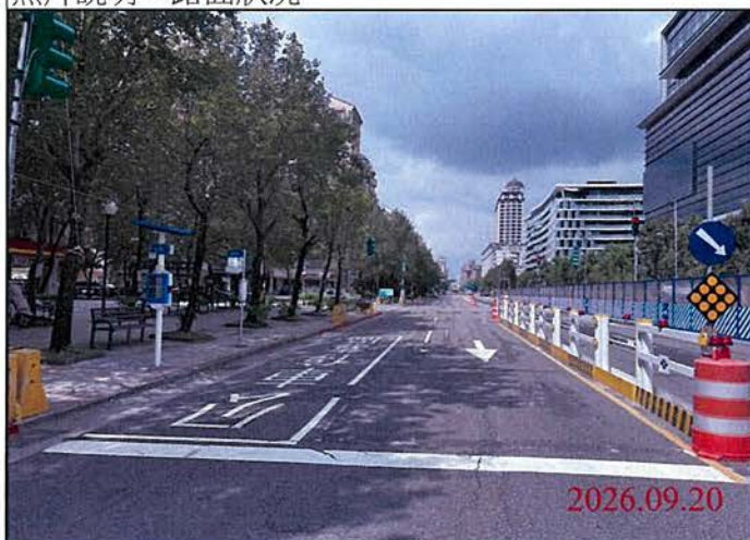
巡查日期地點：115.09.20 Y30車站 照片說明：路面狀況
