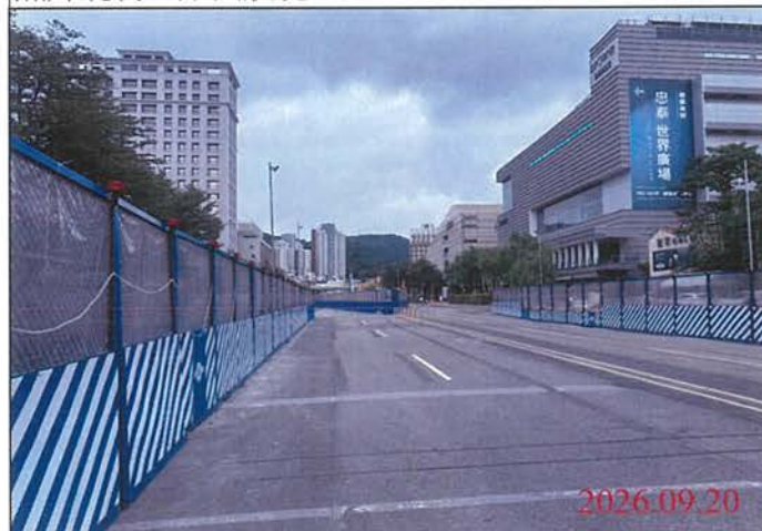
巡查日期地點：115.09.20 尾軌 照片說明：路面狀況
