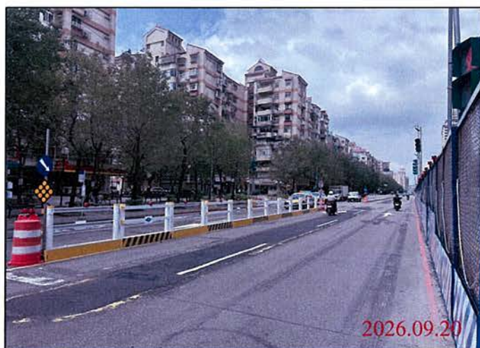
巡查日期地點：115.09.20 Y30車站 照片說明：路面狀況
