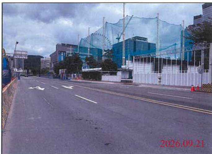
巡查日期地點：115.09.21 尾軌 照片說明：路面狀況
