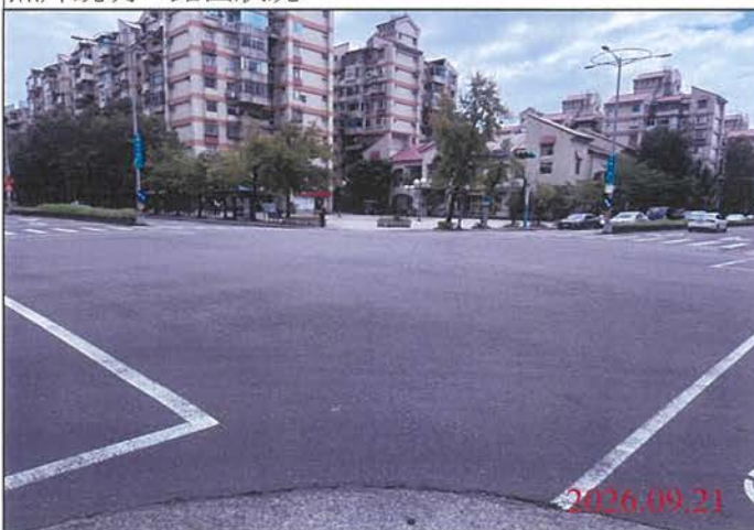
巡查日期地點：115.09.21 尾軌 照片說明：路面狀況
