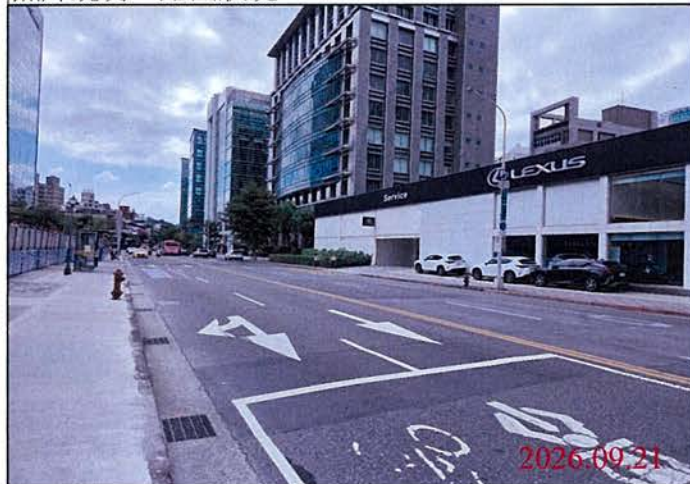
巡查日期地點：115.09.21 Y32車站 照片說明：路面狀況
