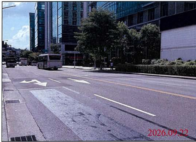
巡查日期地點：115.09.22 Y32車站 照片說明：路面狀況
