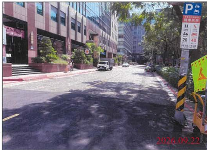
巡查日期地點：115.09.22 Y31車站 照片說明：路面狀況
