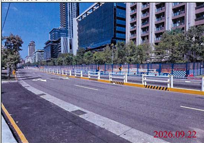
巡查日期地點：115.09.22 Y30車站 照片說明：路面狀況
