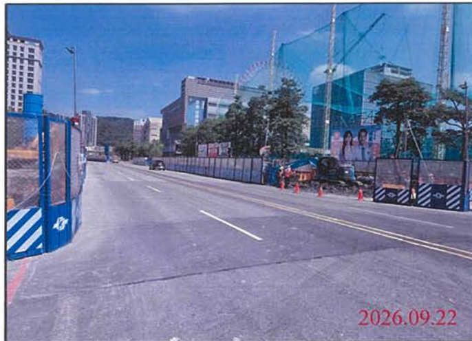
巡查日期地點：115.09.22 尾軌 照片說明：路面狀況
