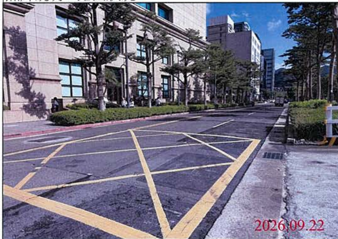
巡查日期地點：115.09.22 Y32車站 照片說明：路面狀況
