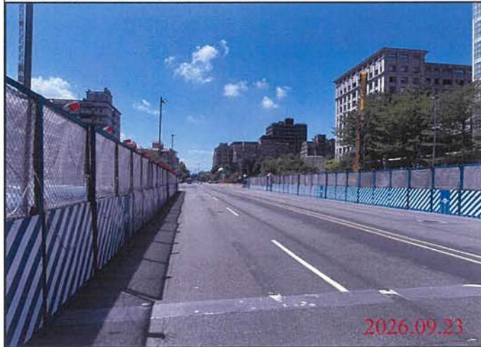
巡查日期地點：115.09.23 尾軌 照片說明：路面狀況
