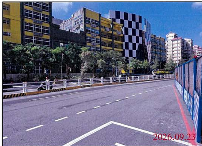
巡查日期地點：115.09.23 Y30車站 照片說明：路面狀況
