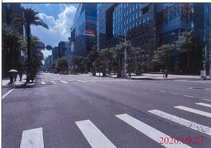
巡查日期地點：115.09.23 Y31車站 照片說明：路面狀況
