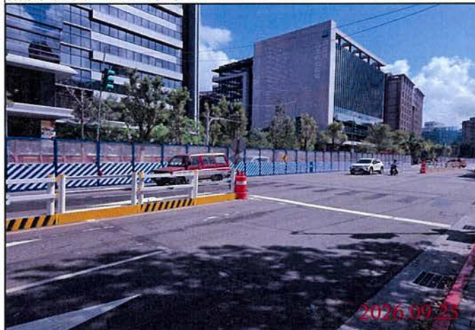
巡查日期地點：115.09.23 Y30車站 照片說明：路面狀況
