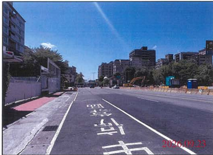
巡查日期地點：115.09.23 尾軌 照片說明：路面狀況
