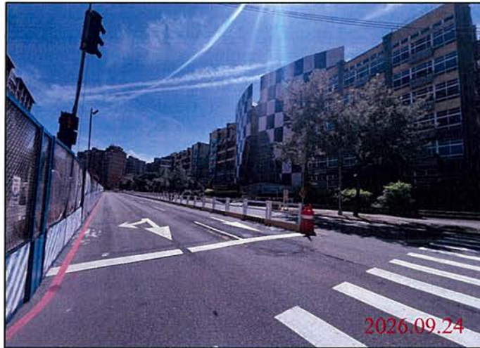
巡查日期地點：115.09.24 Y30車站 照片說明：路面狀況
