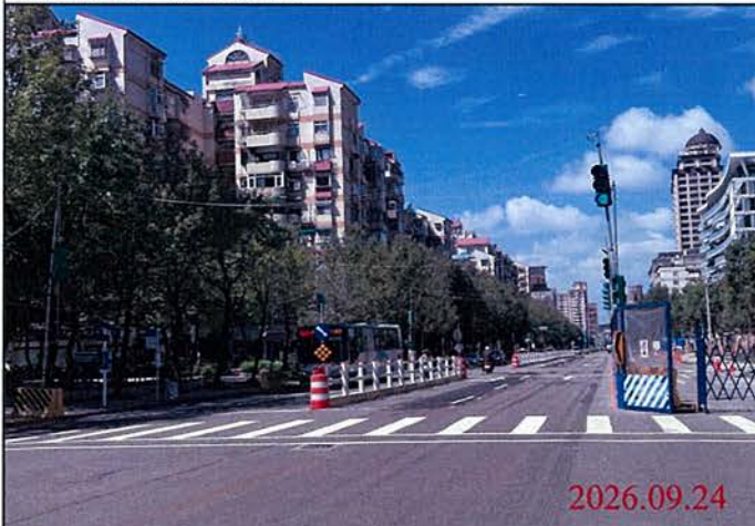
巡查日期地點：115.09.24 Y30車站 照片說明：路面狀況
