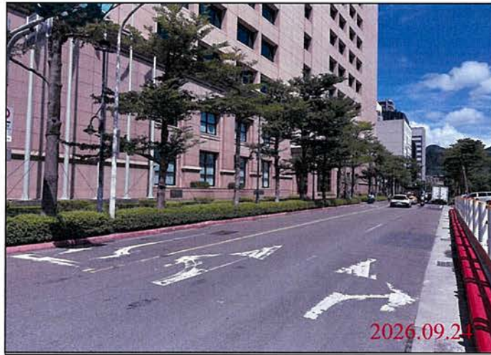
巡查日期地點：115.09.24 Y32車站 照片說明：路面狀況
