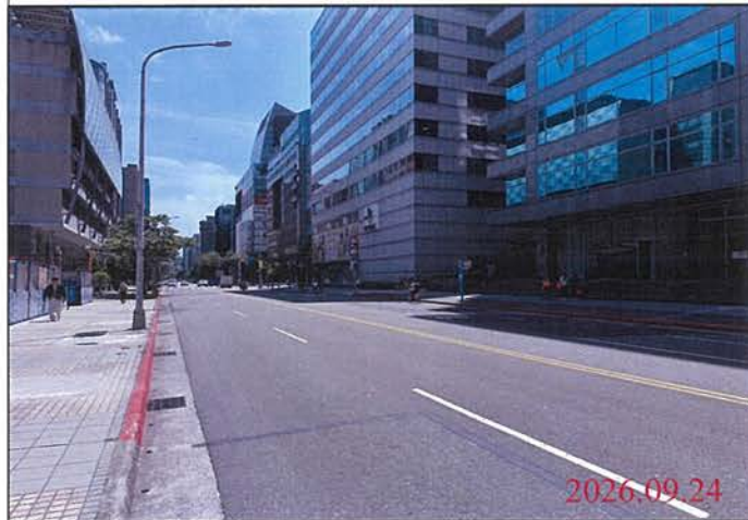
巡查日期地點：115.09.24 Y31車站 照片說明：路面狀況
