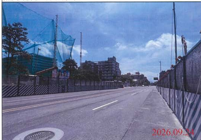
巡查日期地點：115.09.24 尾軌 照片說明：路面狀況
