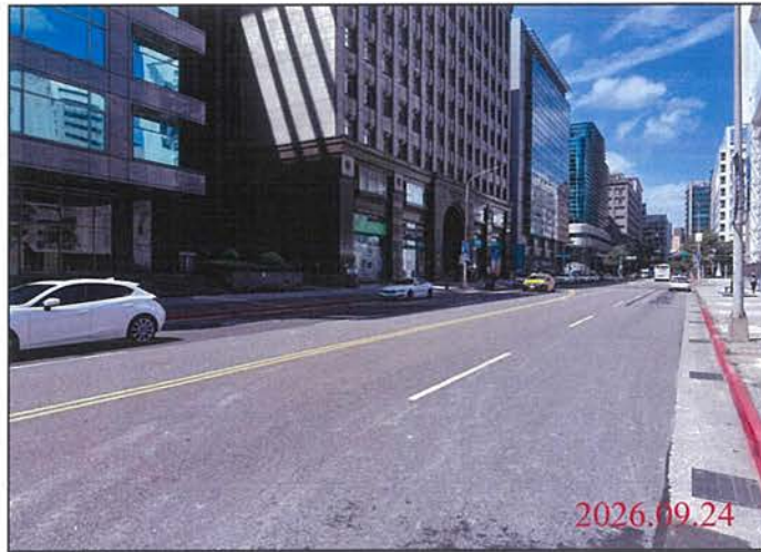
巡查日期地點：115.09.24 Y31車站 照片說明：路面狀況
