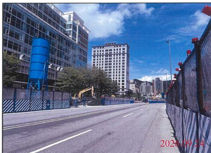
巡查日期地點：115.09.24 尾軌 照片說明：路面狀況
