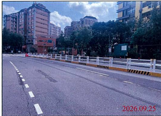
巡查日期地點：115.09.25 Y30車站 照片說明：路面狀況
