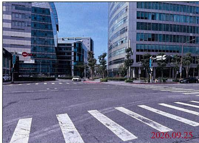
巡查日期地點：115.09.25 Y32車站 照片說明：路面狀況
