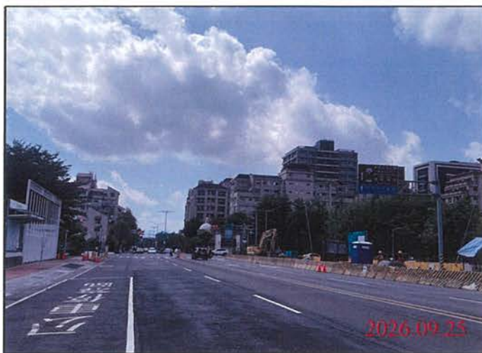
巡查日期地點：115.09.25 尾軌 照片說明：路面狀況
