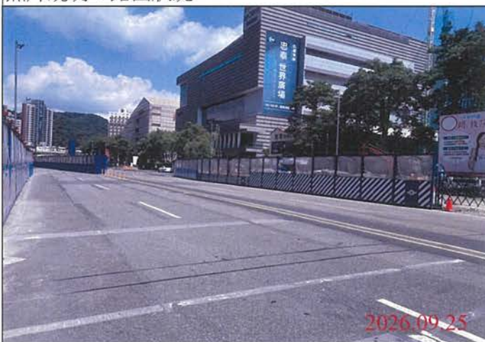
巡查日期地點：115.09.25 尾軌 照片說明：路面狀況
