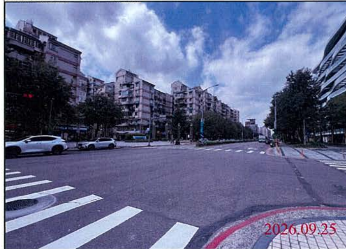
巡查日期地點：115.09.25 Y30車站 照片說明：路面狀況
