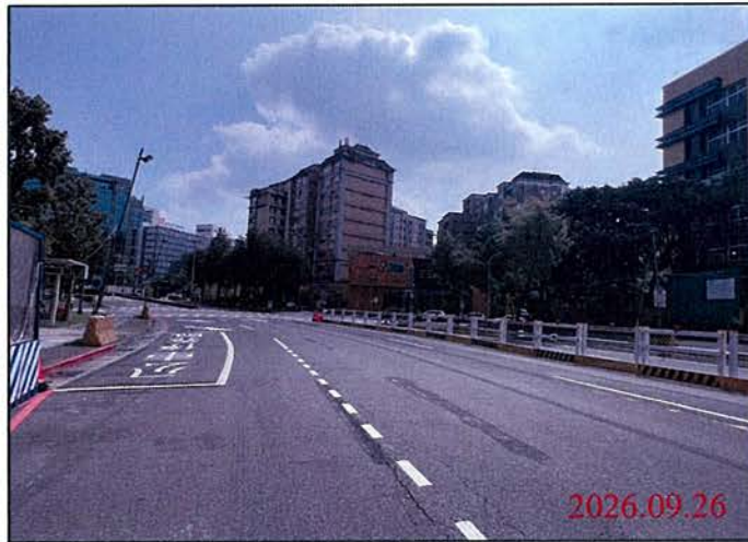
巡查日期地點：115.09.26 Y30車站 照片說明：路面狀況
