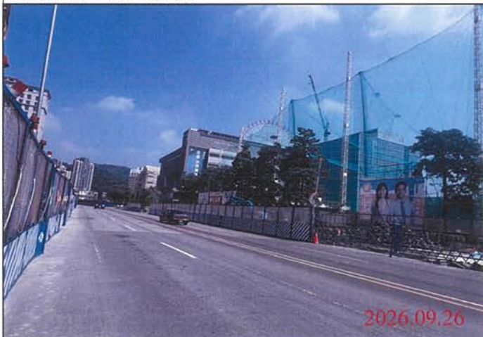
巡查日期地點：115.09.26 尾軌 照片說明：路面狀況
