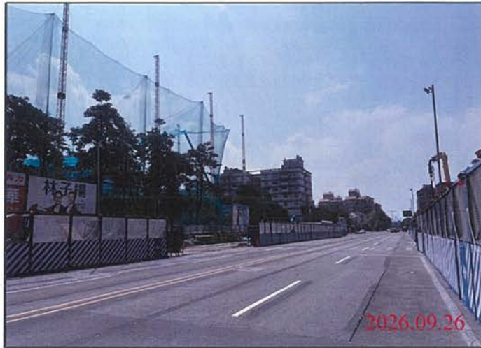
巡查日期地點：115.09.26 尾軌 照片說明：路面狀況
