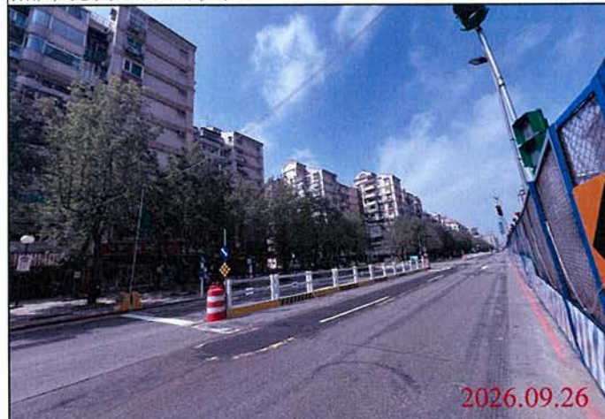
巡查日期地點：115.09.26 Y30車站 照片說明：路面狀況
