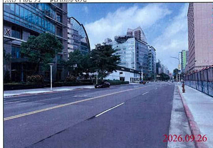
巡查日期地點：115.09.26 Y32車站 照片說明：路面狀況
