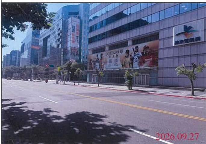
巡查日期地點：115.09.27 Y31車站 照片說明：路面狀況
