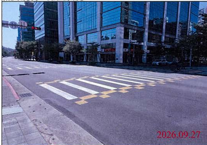
巡查日期地點：115.09.27 Y32車站 照片說明：路面狀況
