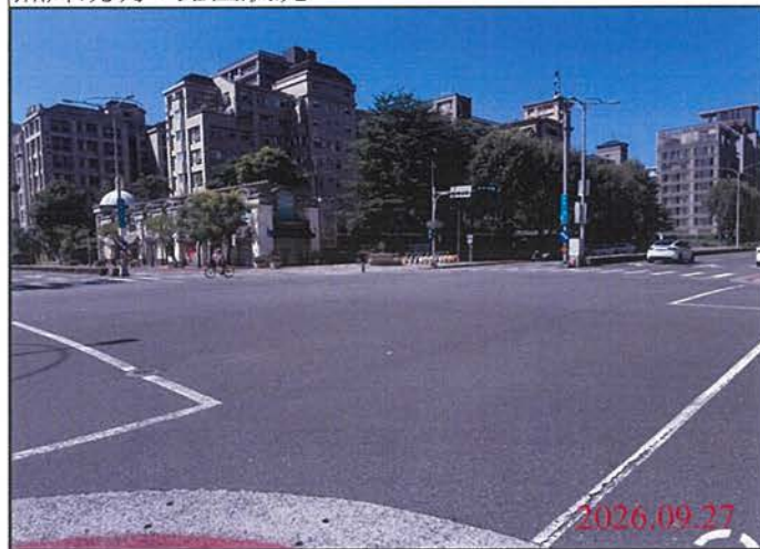
巡查日期地點：115.09.27 尾軌 照片說明：路面狀況
