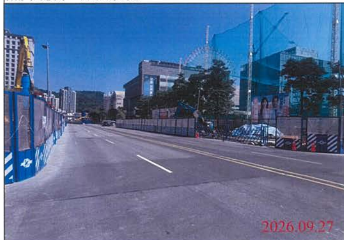
巡查日期地點：115.09.27 尾軌 照片說明：路面狀況
