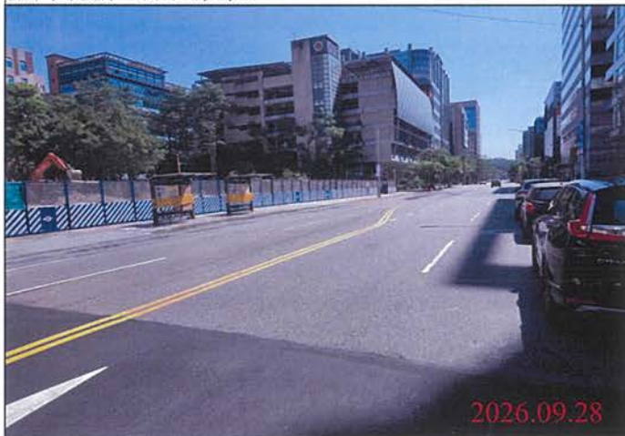
巡查日期地點：115.09.28 Y31車站 照片說明：路面狀況
