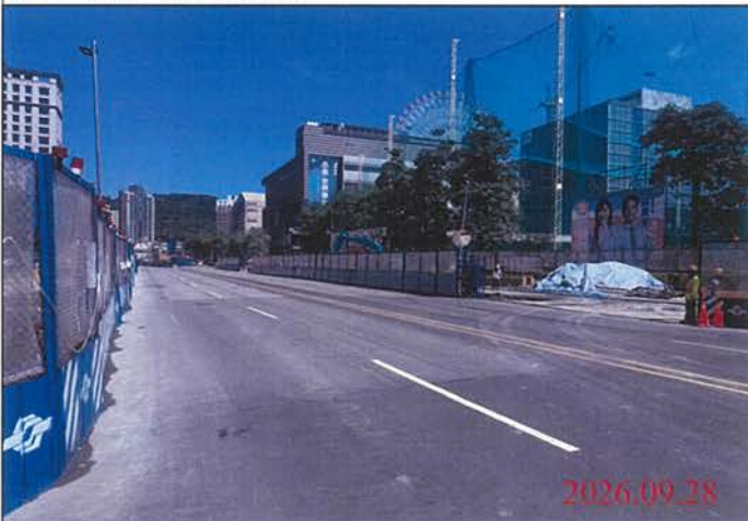
巡查日期地點：115.09.28 尾軌 照片說明：路面狀況
