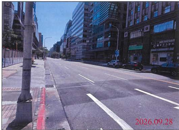
巡查日期地點：115.09.28 Y31車站 照片說明：路面狀況
