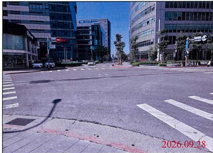
巡查日期地點：115.09.28 Y32車站 照片說明：路面狀況
