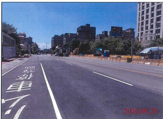
巡查日期地點：115.09.28 尾軌 照片說明：路面狀況
