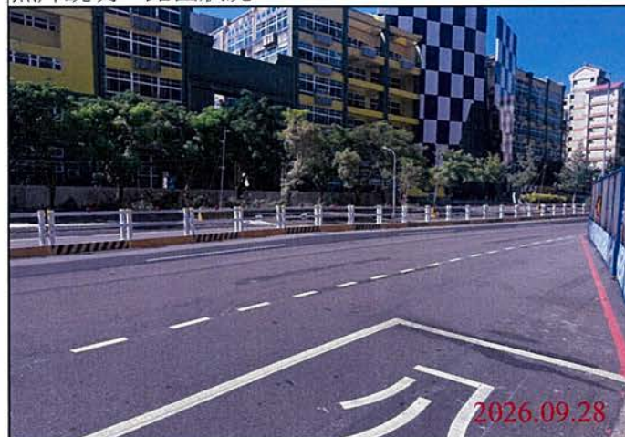
巡查日期地點：115.09.28 Y30車站 照片說明：路面狀況
