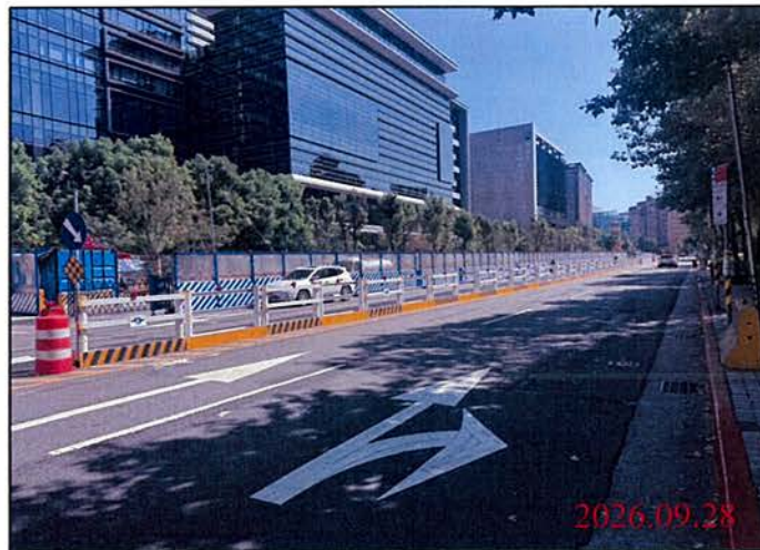
巡查日期地點：115.09.28 Y30車站 照片說明：路面狀況
