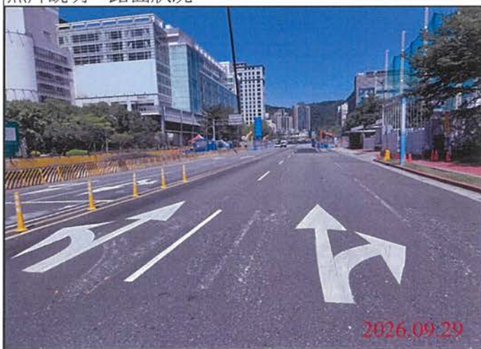
巡查日期地點：115.09.29 尾軌 照片說明：路面狀況
