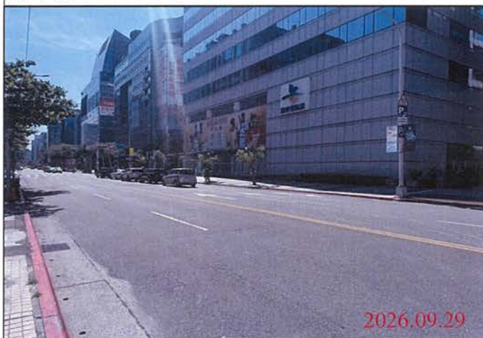
巡查日期地點：115.09.29 Y31車站 照片說明：路面狀況
