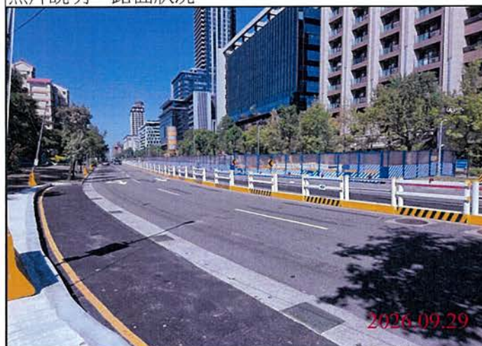
巡查日期地點：115.09.29 Y30車站 照片說明：路面狀況
