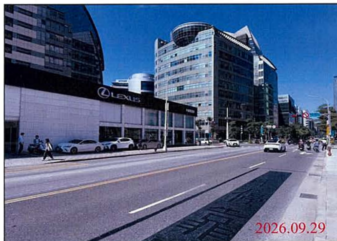
巡查日期地點：115.09.29 Y32車站 照片說明：路面狀況
