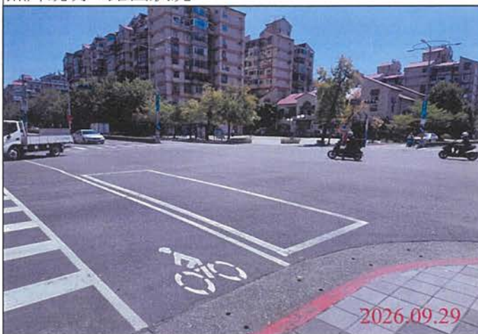
巡查日期地點：115.09.29 尾軌 照片說明：路面狀況
