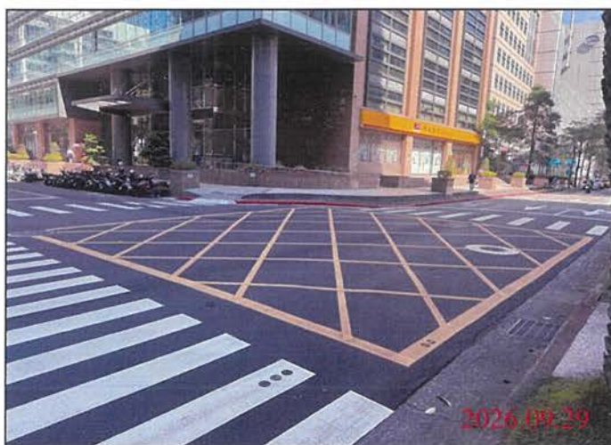
巡查日期地點：115.09.29 Y31車站 照片說明：路面狀況
