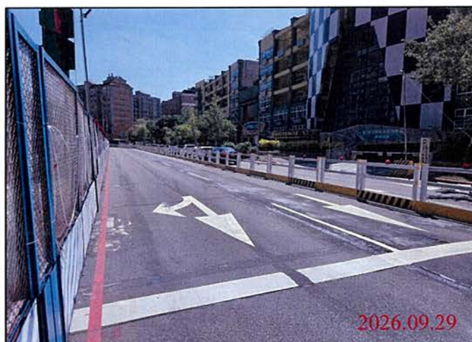
巡查日期地點：115.09.29 Y30車站 照片說明：路面狀況
