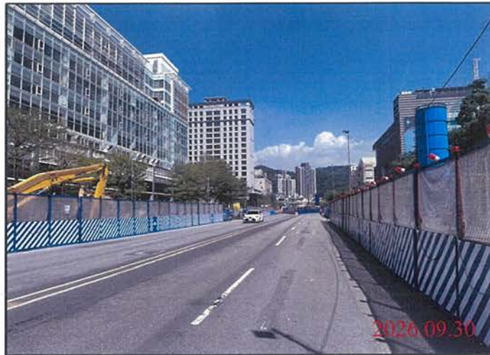
巡查日期地點：115.09.30 尾軌 照片說明：路面狀況
