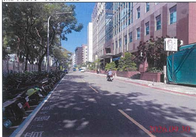
巡查日期地點：115.09.30 Y31車站 照片說明：路面狀況
