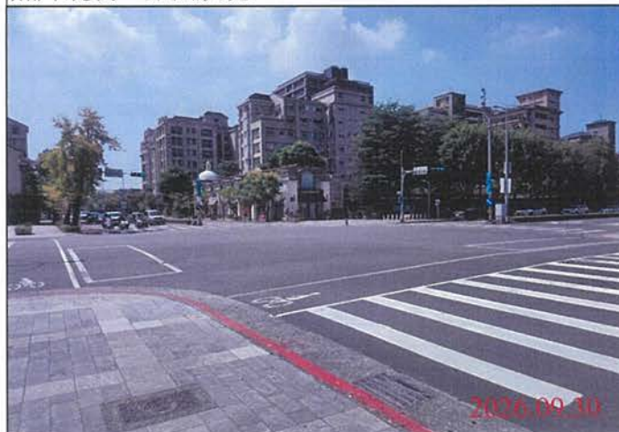
巡查日期地點：115.09.30 尾軌 照片說明：路面狀況
