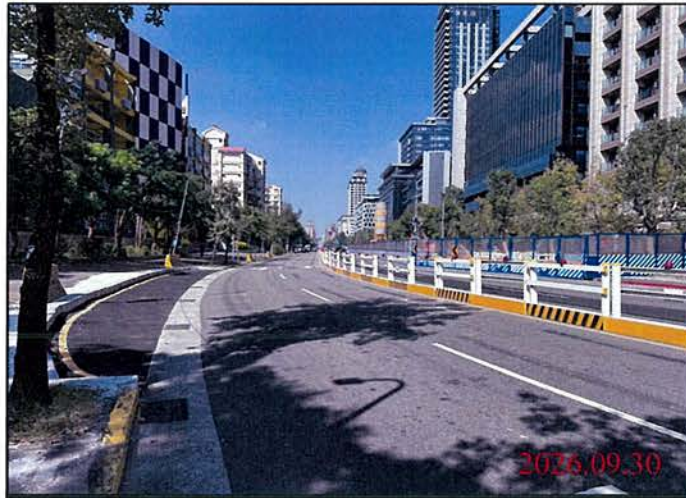
巡查日期地點：115.09.30 Y30車站 照片說明：路面狀況
