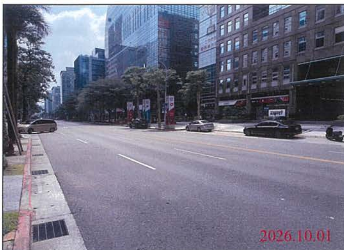
巡查日期地點：115.10.01 Y31車站 照片說明：路面狀況
