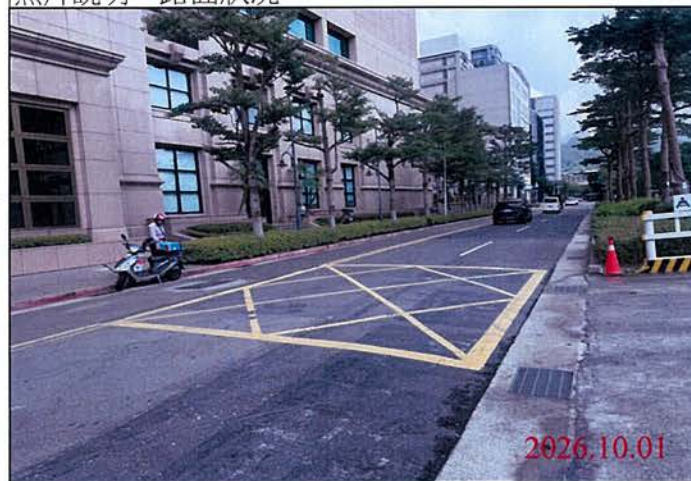
巡查日期地點：115.10.01 Y32車站 照片說明：路面狀況
