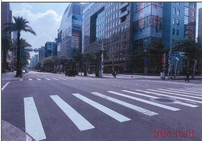
巡查日期地點：115.10.01 Y31車站 照片說明：路面狀況
