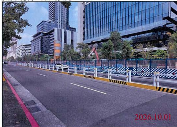
巡查日期地點：115.10.01 Y30車站 照片說明：路面狀況
