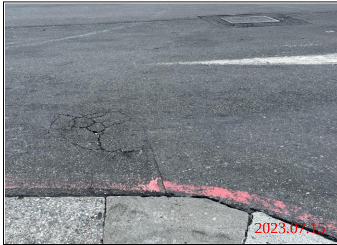
巡查日期地點：112.07.15/ Y21車站 照片說明：路面龜裂狀況
