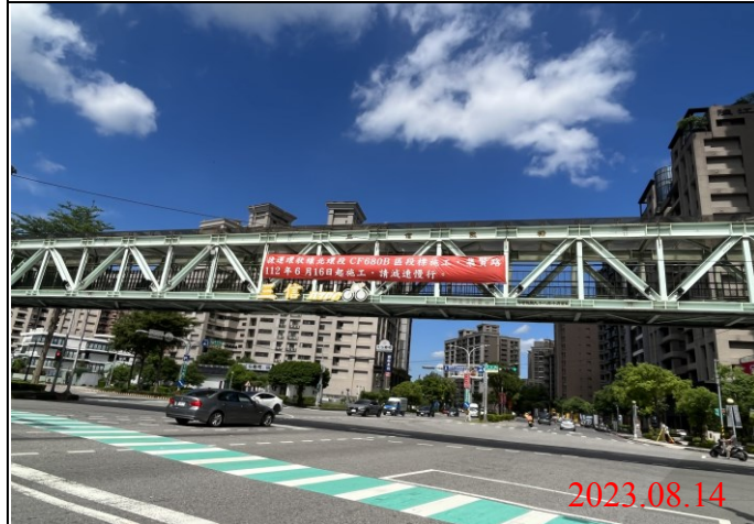
巡查日期地點：112.08.14/ Y23車站 照片說明：牌面設置狀況
